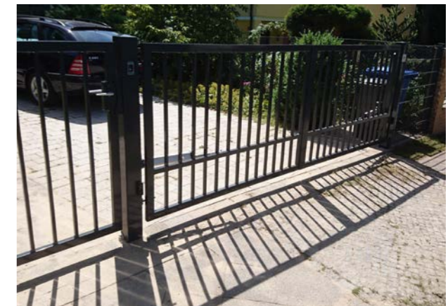
METALLTORANLAGE AUS PFORTE- UND DOPPELTOR mit el. Drehtorantrieb aus Rechteckstahlprofil in RAL 9005 Tiefschwarz Nr. 3004
