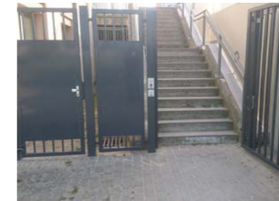
METALLTORANLAGE mit Sicherheitseinrichtung und Eingriffsschutzplatten gegen Vandalismus in RAL 7016 anthrazit Nr. 4010
