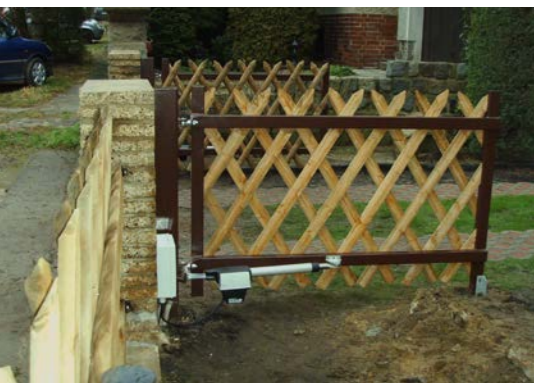
DOPPELTORANLAGE MIT STAHLRAHMEN UND JÄGERZAUNAUFLETTUNG Rahmen feuerverzinkt und pulverbeschichtet in RAL 8017 Schokoladenbraun Nr. 6002
