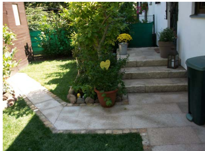
GEPFLASTERTER GEHWEG mit Granitgehwegplatten und Randeinfassung mit passenden Pflastersteinen Nr. 8014
