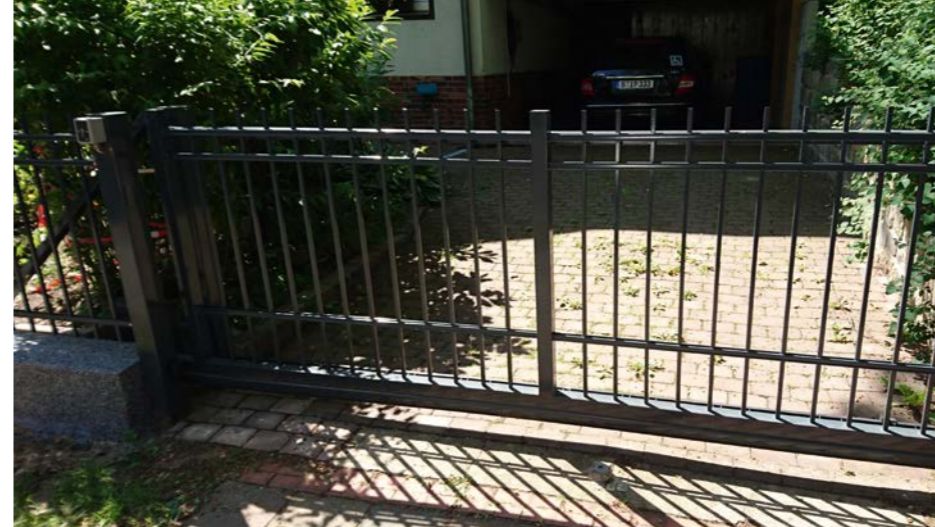
SCHMIEDEEISERNE SCHIEBETORANLAGE freitragend aus Hespeneisen und Vierkantstahlfüllung mit U-Stahl Rahmen in RAL 7016 anthrazit Nr. 6003
