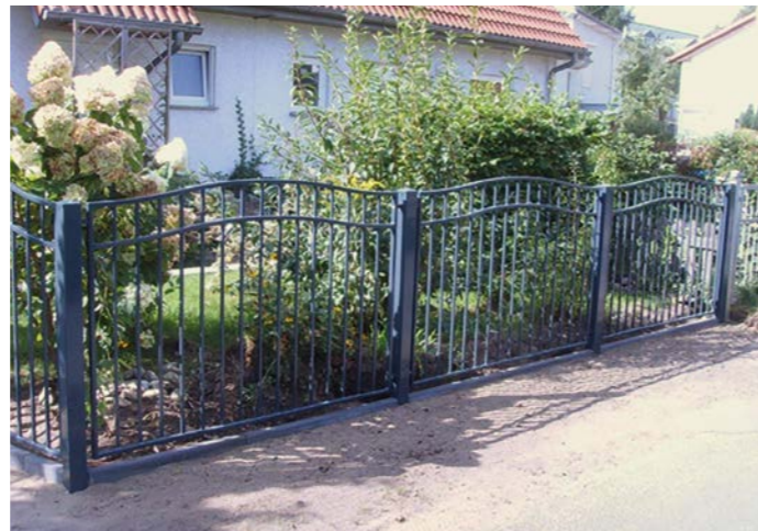
METALLZAUNANLAGE mit 2-fachen Schweißbogen, Vierkantstahlfüllung und Rahmen in RAL 7016 anthrazit Nr. 3008
